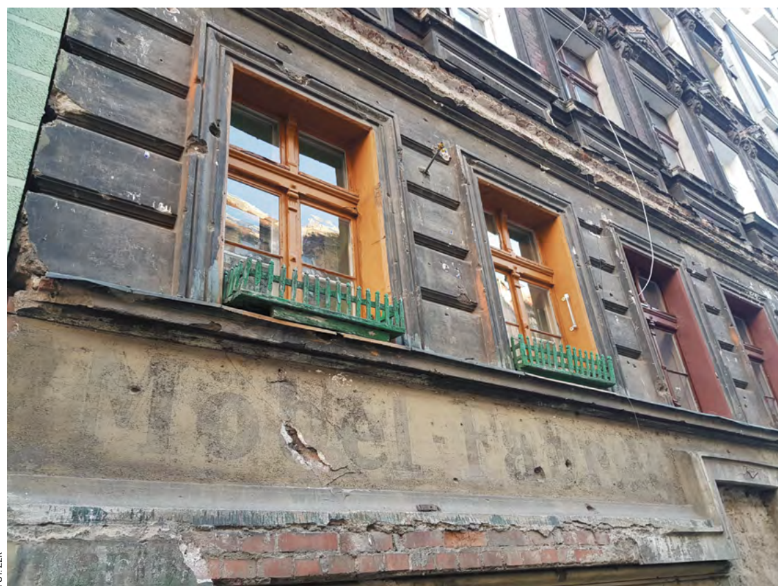
Podczas remontu elewacji odtworzony zostanie niemiecki napis „Möbel-Farb” A. Scholz
